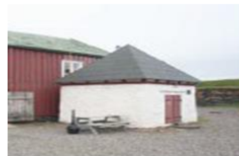
Navn: 0010 Brønnhuset Byggeår: 1738
