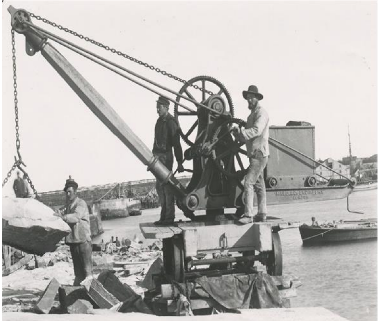
Under byggingen av moloene ble det laget dagbrudd for stein på begge sider av Nordre Våg for å forsyne moloene med byggematerialer. Man kan se spor av disse dagbruddene i landskapet på nordøstlig side av Vestervågen og i boligfeltene på skagen. Fotografi fra 1880-tallet. Kilde: Varanger Museum IKS
