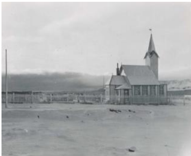
I begynnelsen var kapellet lite brukt da folk flest ønsket fortsatt å gjennomføre begravelser i byens kirke. Kilde: Varanger Museum IKS.
