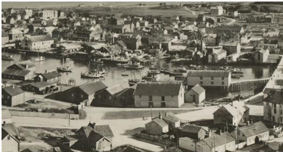
Fotografi fra rundt 1935. Dette er trolig fra før selve Lærebruket ble etablert, men viser hvor anlegget ligger i dag. I forkant ser man Kaigata. Kilde: Varanger Museum IKS.
