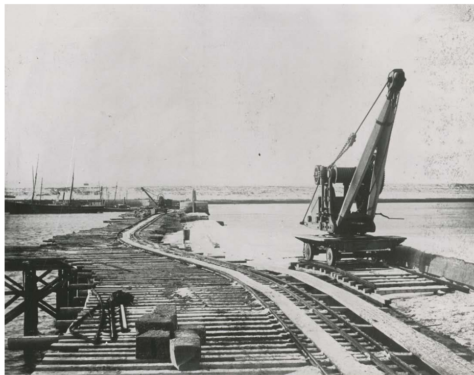
Fotografi fra 1880-tallet som viser byggingen av moloene i tilknytning Nordre Våg. Jernbanesporene ble benyttet for å transportere byggematerialer ut til moloene og flytte kranene. Kilde: Varanger Museum IKS
