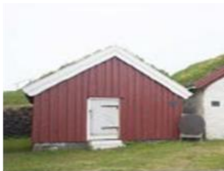
Navn: 0007 Ladetøyhuset Byggeår: 1813/1854
