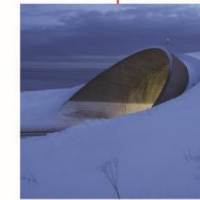
Fastlandsforbindelsen: Tunnelen under Bussesundet ble ferdigstilt
